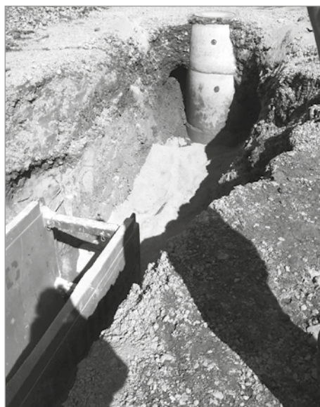
Poslední metry kanalizace
