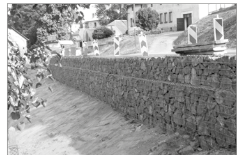
Stavba gabionové zdi
