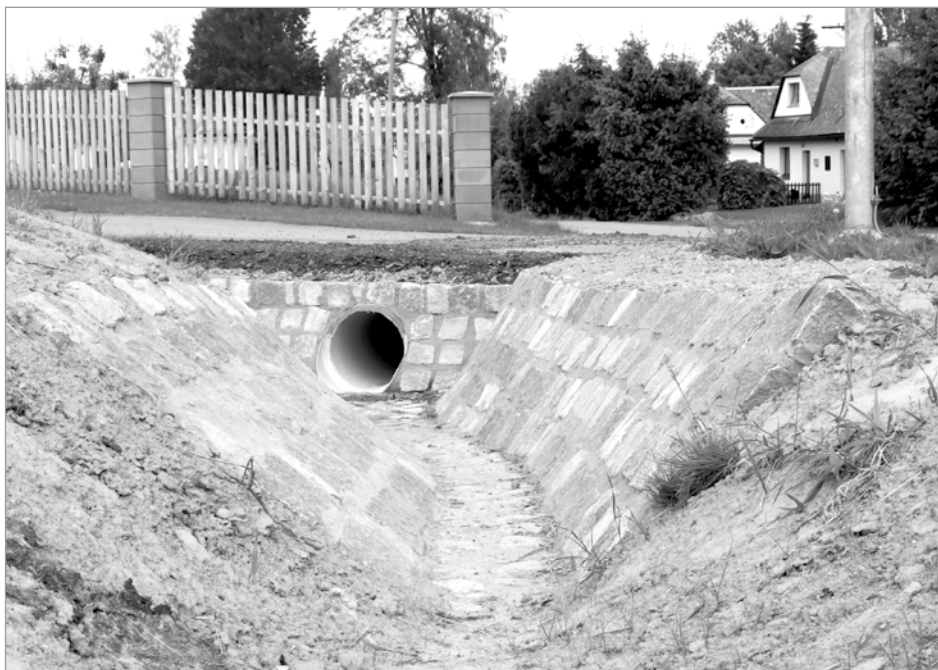
Kanalizace u cesty od střelnice
